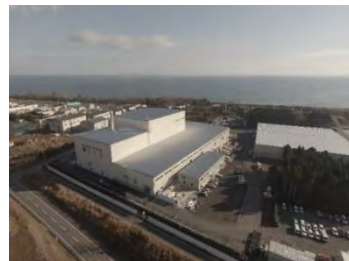
大熊町の仮設焼却施設
